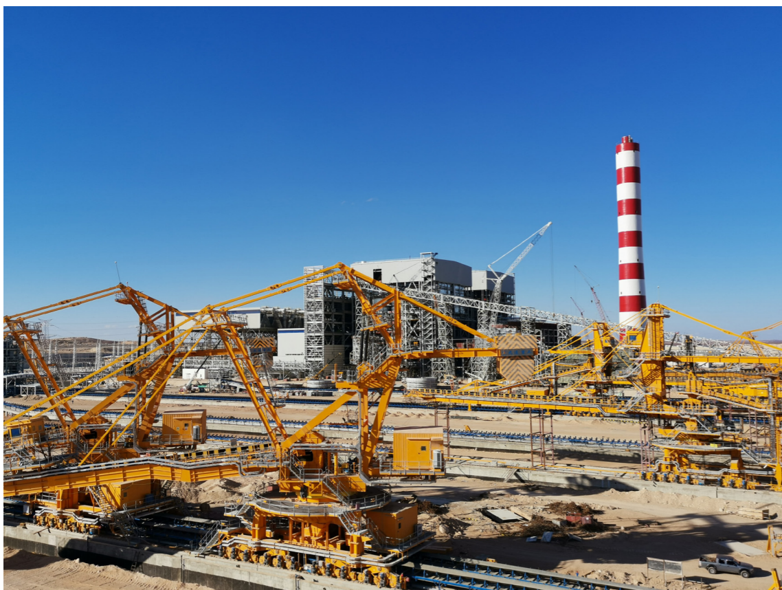
约旦阿塔拉特电站工程现场
