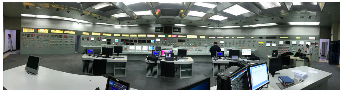
▼ 改造后的秦山核电站主控制室
